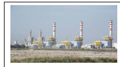
10 miliardi di chilowattora l'anno, è la più potente tra quelle della Società Eni. La centrale, inoltre, produce energia termica (vapore) destinata ad uso industriale. L'alimentazione a gas naturale è garantita da un gasdotto sotterraneo lungo circa 14 km.
