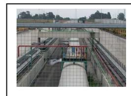
Il nastro (con una capacità di 2000 t/h) si sviluppa in parte in trincea e in parte su viadotto.
